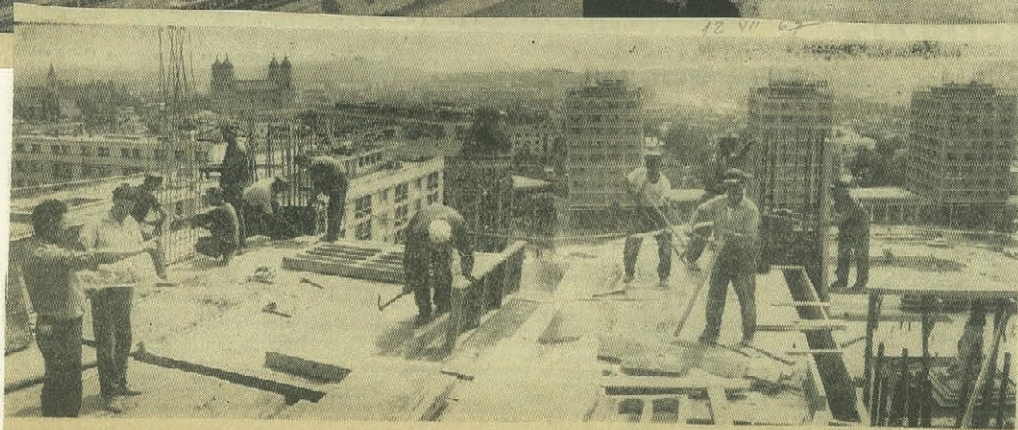
Santierul 41, hotel Piața Unirii Iași. În aceste zile constructorii lucrează la montarea cofrajelor și a fierului-beton la etajul 6.
