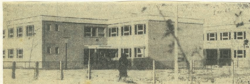
Noua construcție a creșei (160 de locuri) și a grădiniței de copii (200 de locuri) din cartierul Socol Nicolina.
