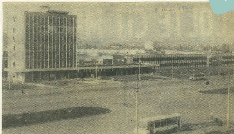
Imagine din Iași industrial: noua și modernă Tesătorie de mătase „Victoria”.
