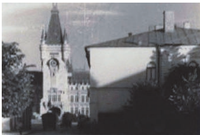
Fig. 1. Casa Ghika-Daniel c. 1940, vedere dinspre nord
